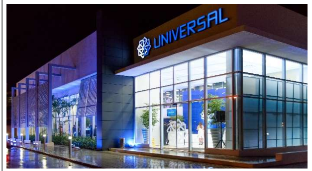
Edificio Universal Zona Oriental
