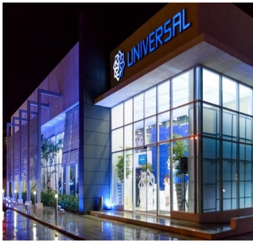
Edificio Universal Zona Oriental
