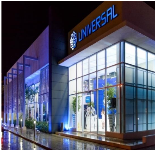
Edificio Universal Zona Oriental
