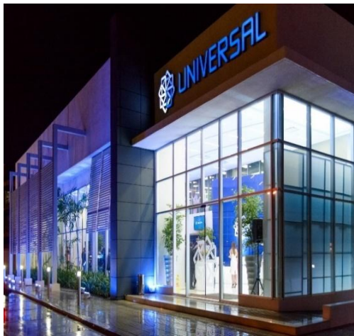
Edificio Universal Zona Oriental
