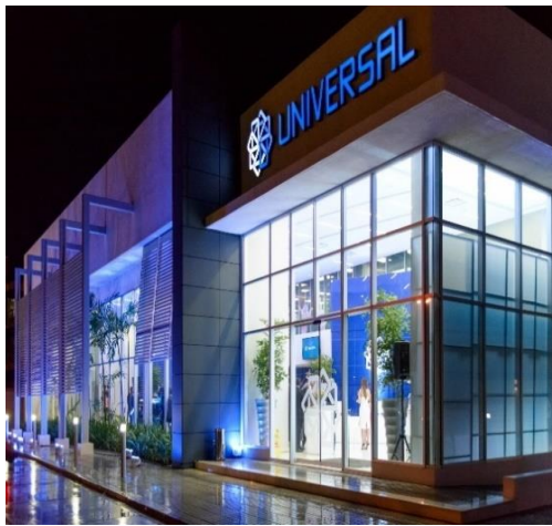
Edificio Universal Zona Oriental
