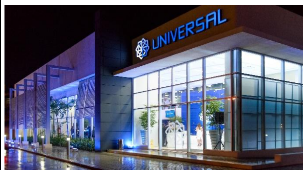
Edificio Universal Zona Oriental
