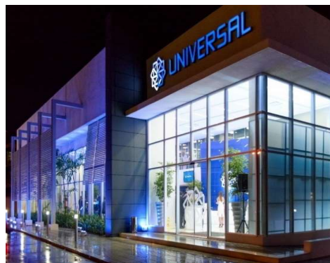
Edificio Universal Zona Oriental
