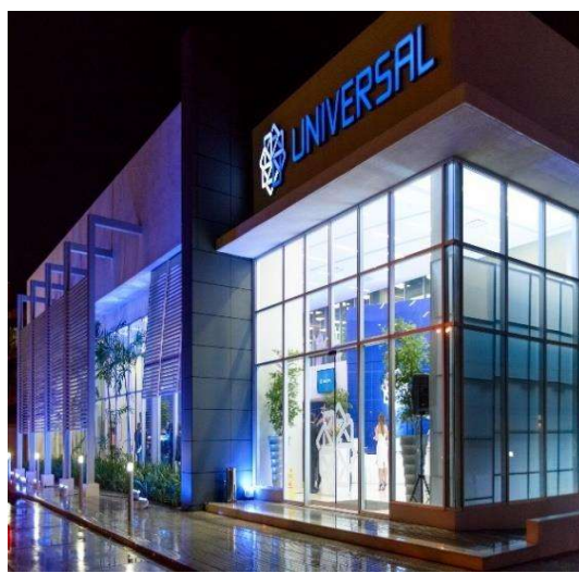
Edificio Universal Zona Oriental
