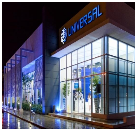
Edificio Universal Zona Oriental
