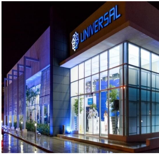
Edificio Universal Zona Oriental
