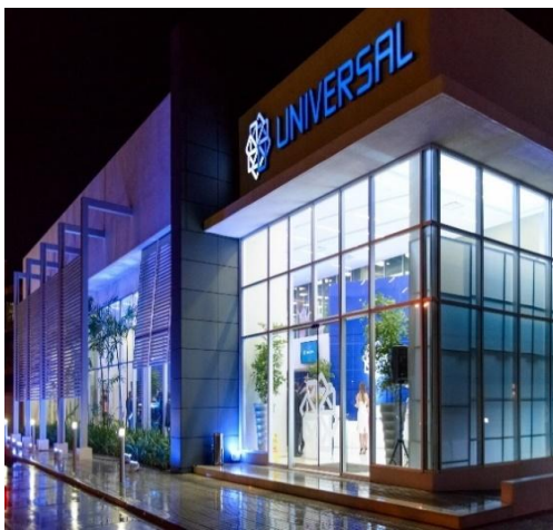
Edificio Universal Zona Oriental
