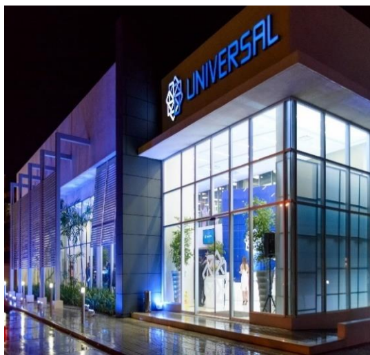
Edificio Universal Zona Oriental
