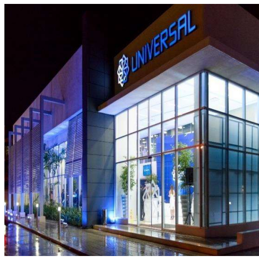
Edificio Universal Zona Oriental
